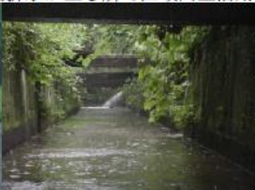
中央高速道路の路面排水が至る所で区域内生活用水路へ処理されている(要注意)
