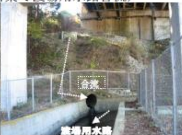
中央高速道路の路面排水が至る所で区域内生活用水路へ処理されている(要注意)
