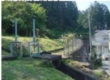
町民グラウンド東側「降雨・降雪」排水側溝 (第1駐車場から暗渠で渡場用水路合流)
