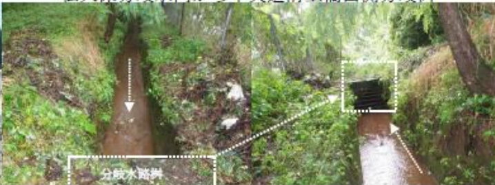
町民グラウンド東側「降雨・降雪」排水側溝 (第1駐車場から暗渠で渡場用水路合流)
