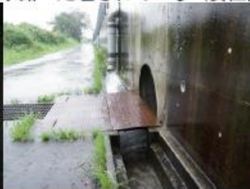
中央高速道路の路面排水が至る所で区域内生活用水路へ処理されている(要注意)
