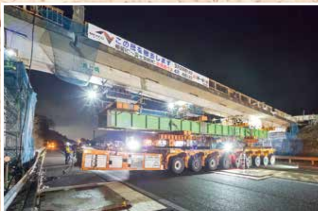
解体前の溝上橋と橋運搬用の移動多軸台車
