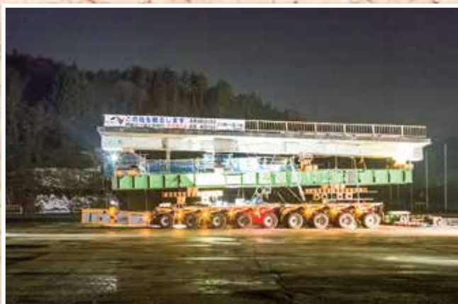
町民グラウンドに運ばれた橋の中央部
