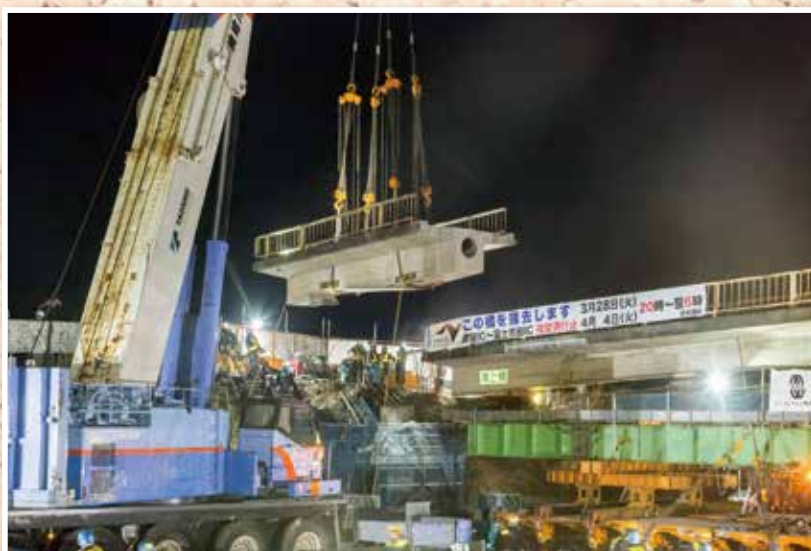
巨大クレーンで吊り上げられる橋の端部
