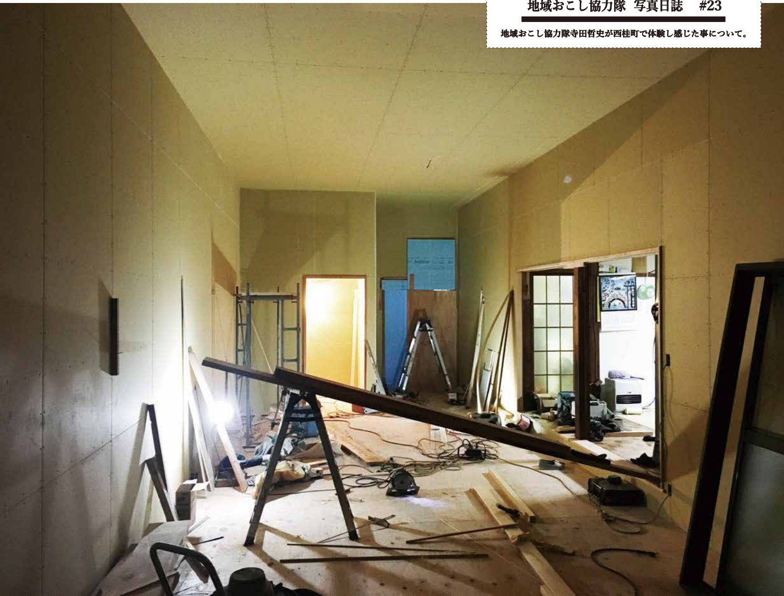
□活動拠点のリノベーション。高い天井と壁面が多いギャラリーになる予定。
