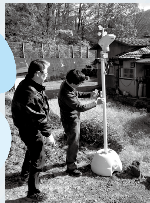
雨量計センサー設置の様子
