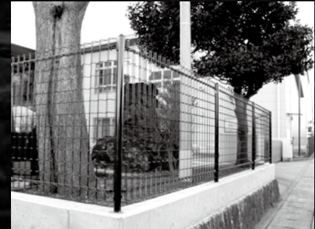
ブロック塀を撤去し小学校に設置されたフェンス
