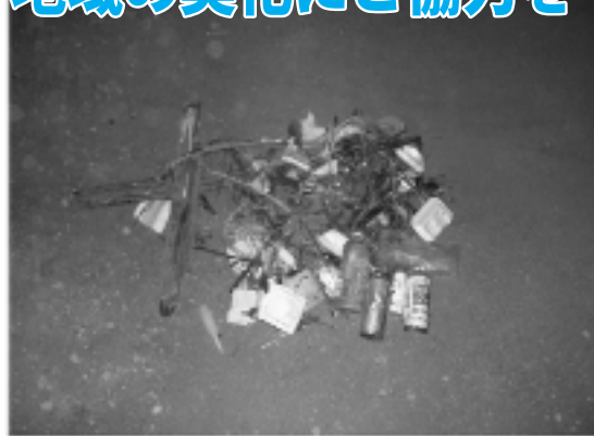
側溝を詰まらせたゴミ
