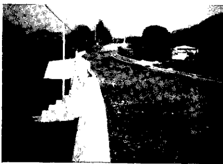
尾尻農道 53年度施工地点入口より三〇〇メートル附近
