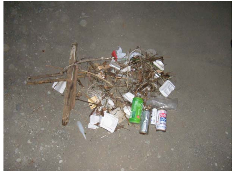
側溝を詰まらせたゴミ
