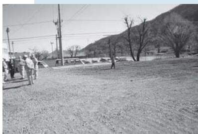
教職員住宅解体後の状況
