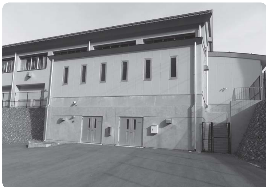
災害用備蓄を行う防災倉庫（中学校体育館裏）
