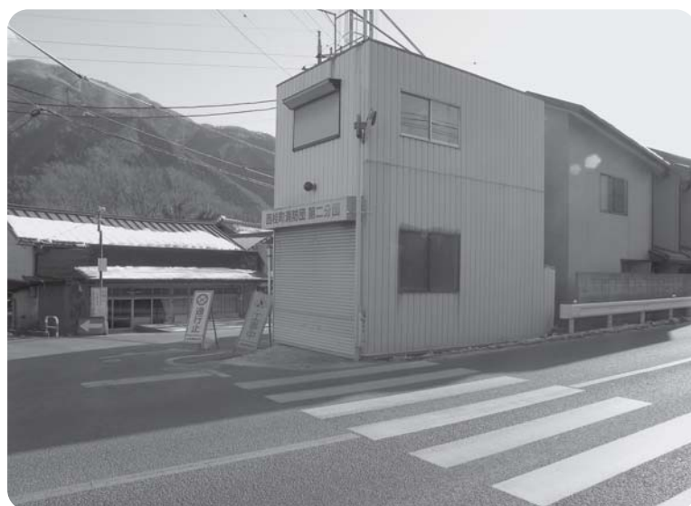
現在は使われていない旧柿園消防詰所
