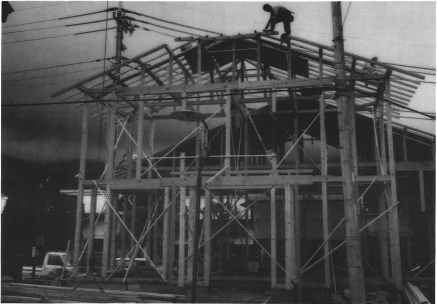
(建設中の倉見公民館)
