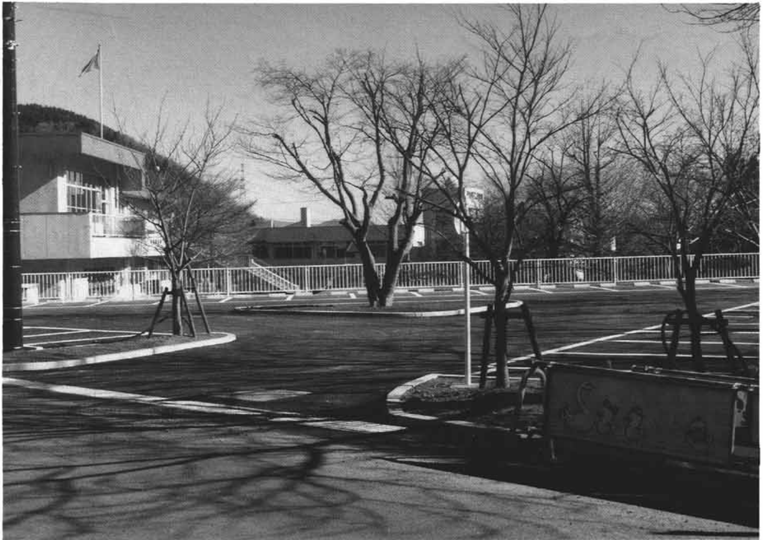
(完成直前の(仮称)健康管理センターA駐車場)
