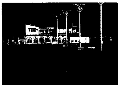
グリーンセンター施設（中央建物は管理棟）
