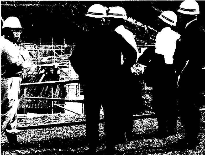
桂川清流センター建設現場で説明を聞く
