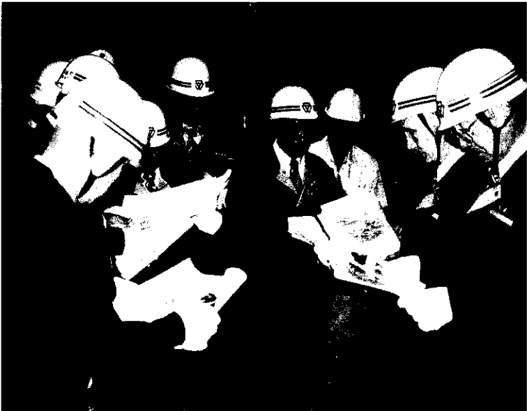
梨木ヶ原トンネル現場地下工区を視察
