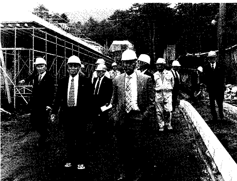
富士五湖聖苑工事現場を視察する町議会
