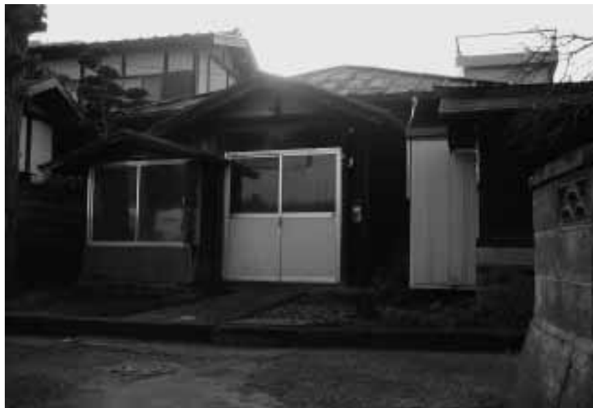
公民館建設に向けて動き出した柿園区
