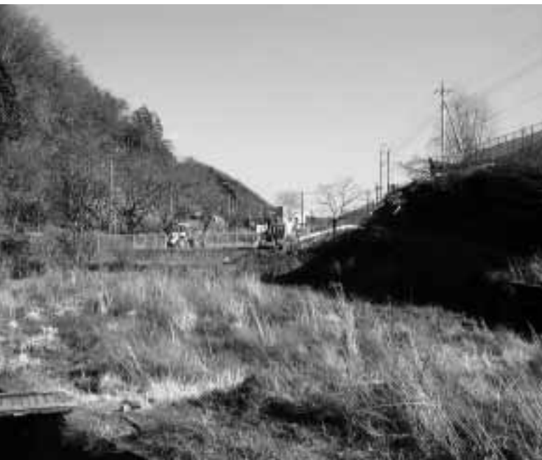
造成が始まった中学校裏町有地
