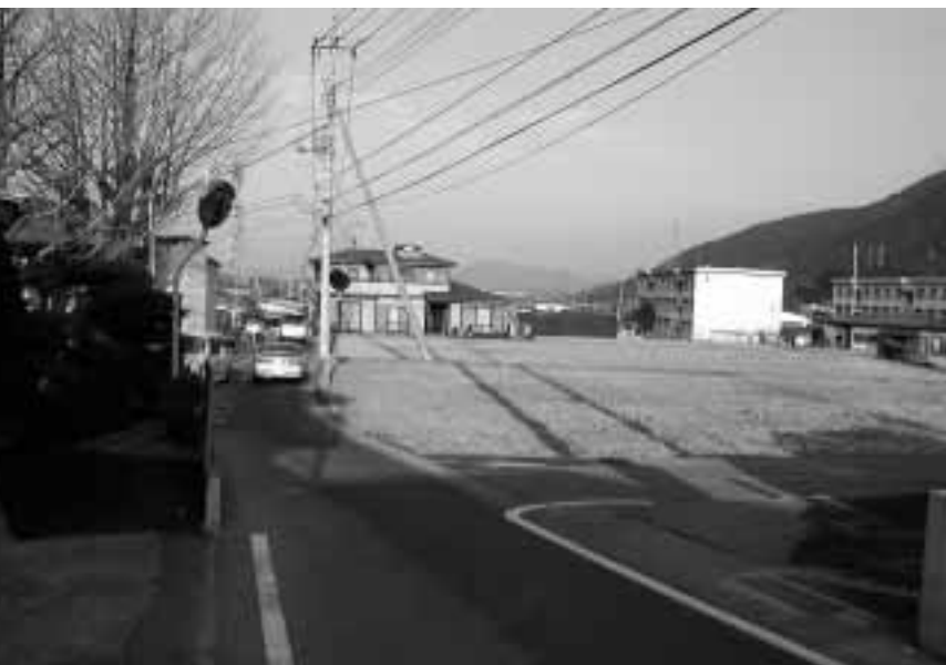
車一台がやっとの小沼都町線と浅間団地方面の迂回路
