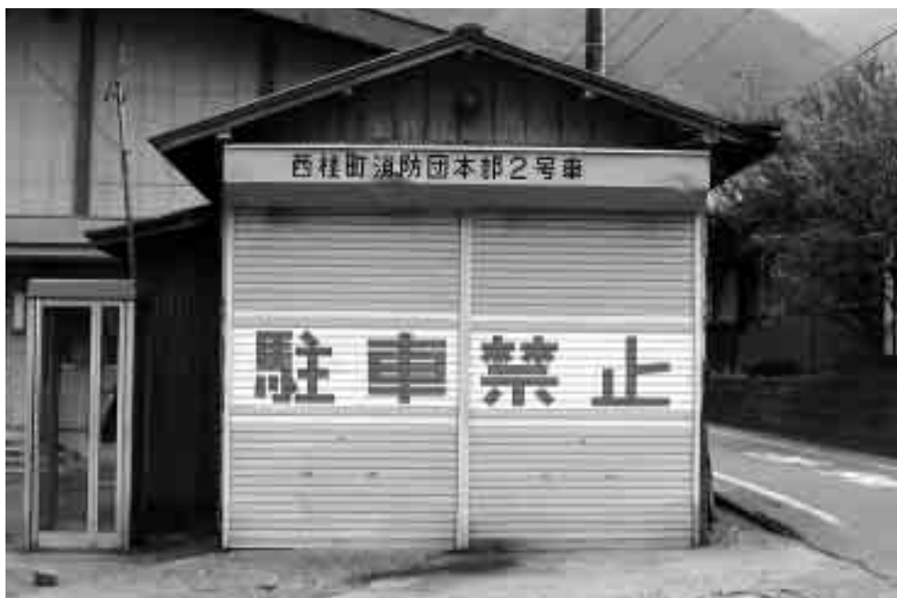
廃止・解体が決まった消防本団2号車車庫
