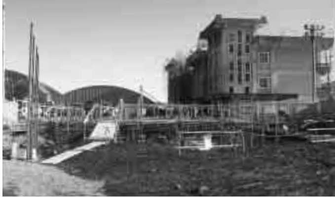
着々と進む中学校校舎建築主体工事
