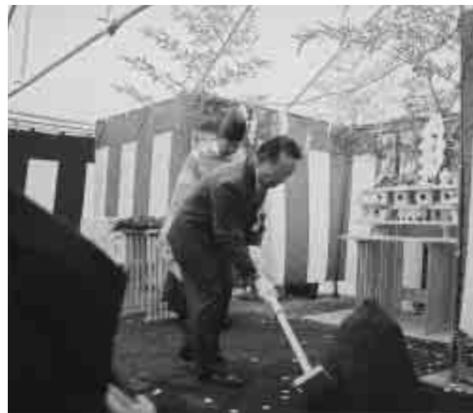
町長の鍬入れで中学校校舎建設工事に着工
