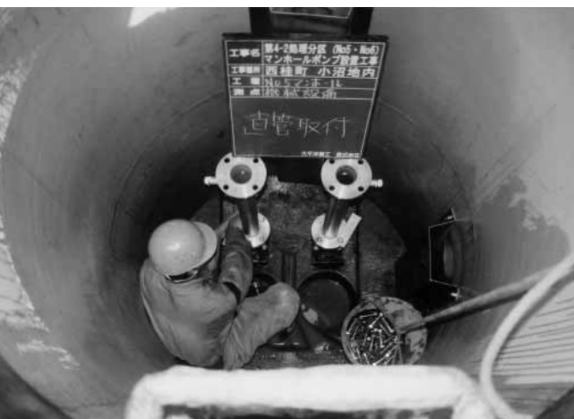
着々と進む下水道工事
