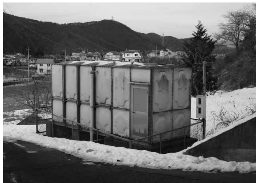
再活用が望まれる倉見貯水槽
