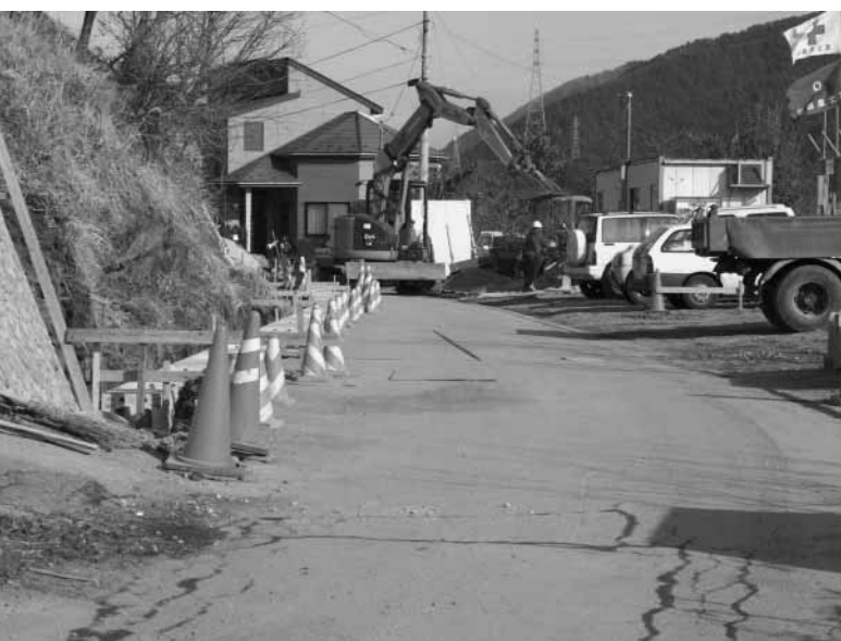
順調に工事の進む宮下中野線
