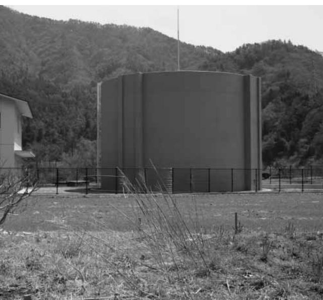
第2新高区配水池予定地（タンク手前）
