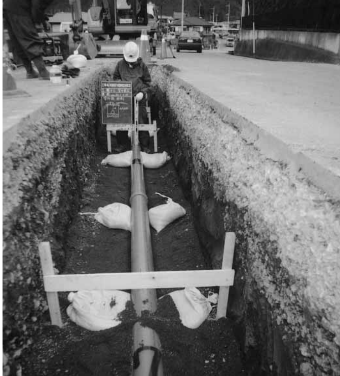
着々と進む下水道工事
