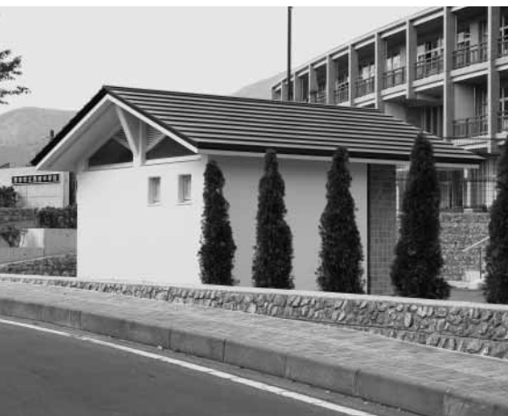
完成した中学校屋外トイレ
