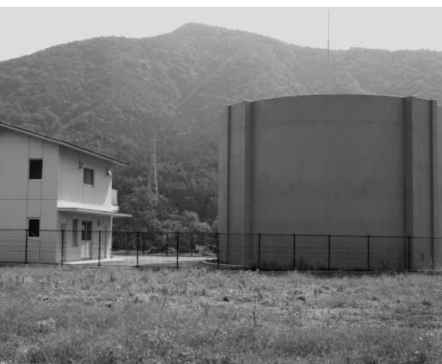
第2新南区配水池予定地（タンク手前）
