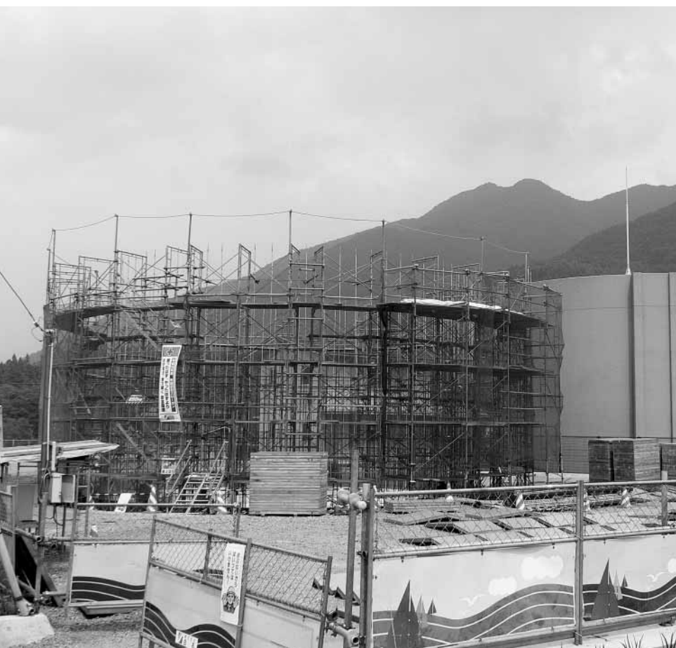
建設中の新高区配水池
