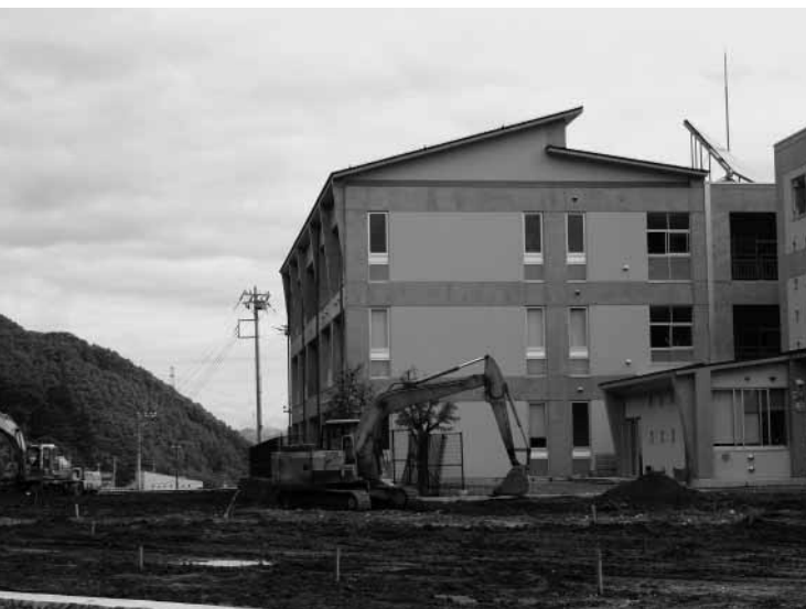
工事中の中学校テニスコート
