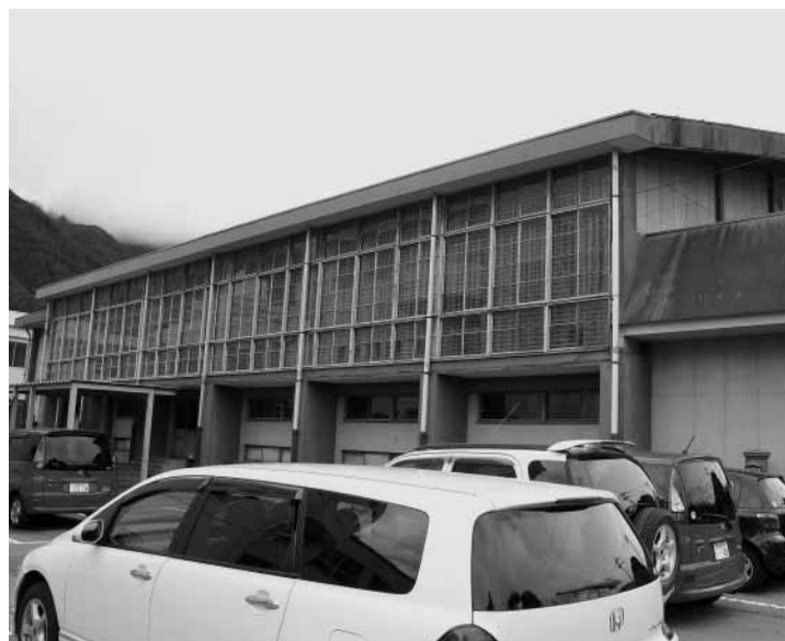
西桂小学校体育館、築32年
