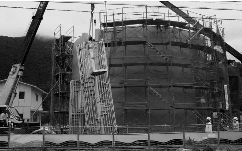
工事中の新高区配水池
