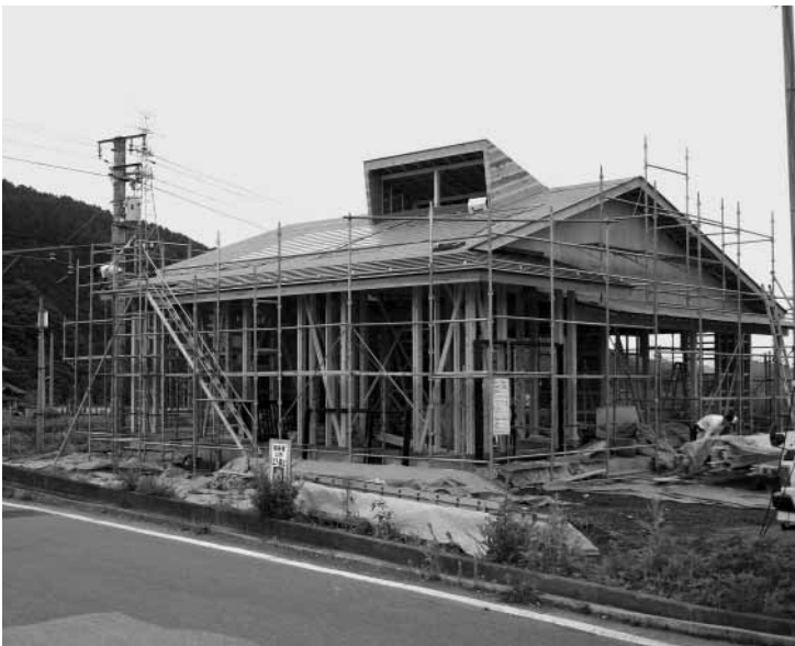
建設中の柿園公民館
