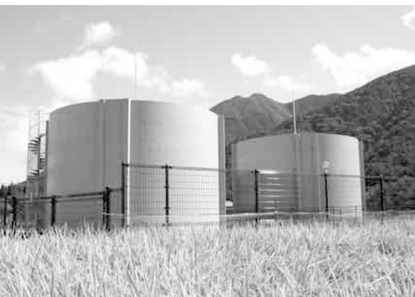
2基の水道タンク
