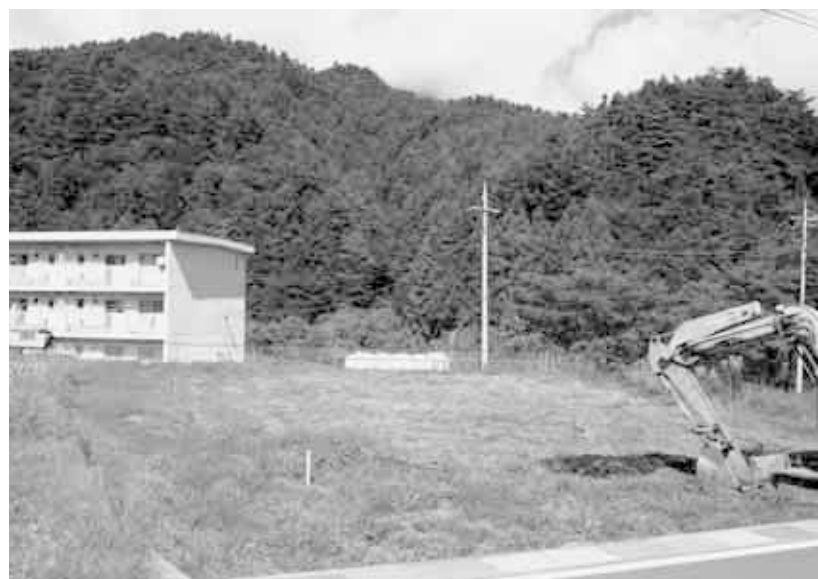
町営中野団地駐車場の予定地
