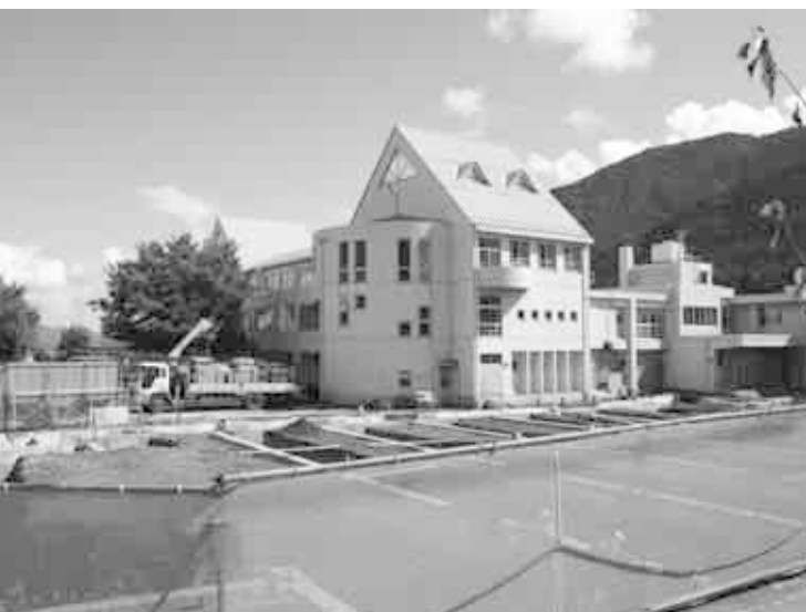
建設中の小学校体育館
