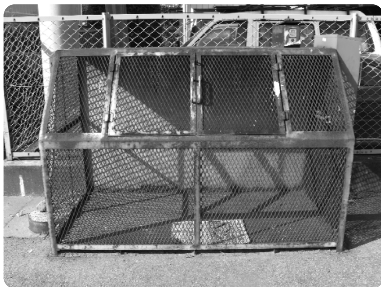
傷みの目立つゴミステーション
