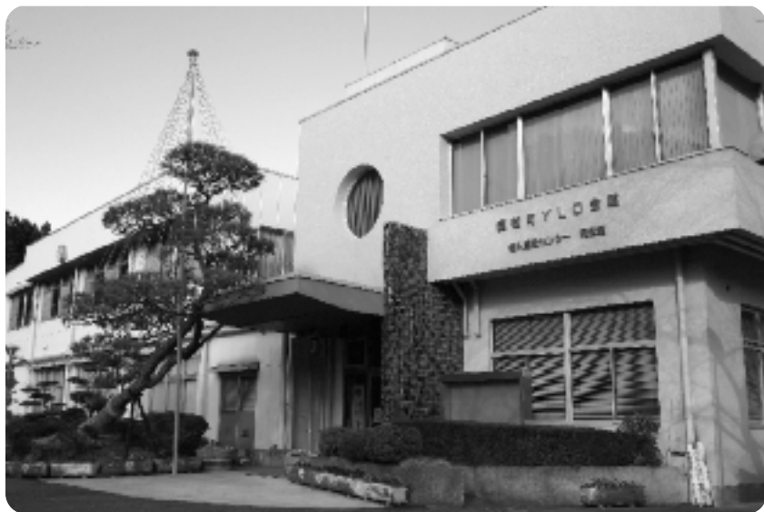
保育所改装中に仮園舎となるYLO会館
