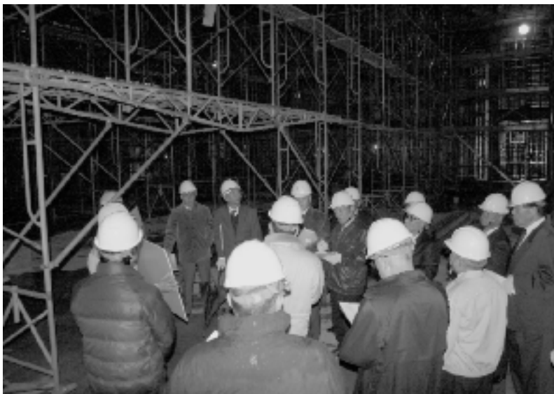
中学校屋内運動場内部視察
