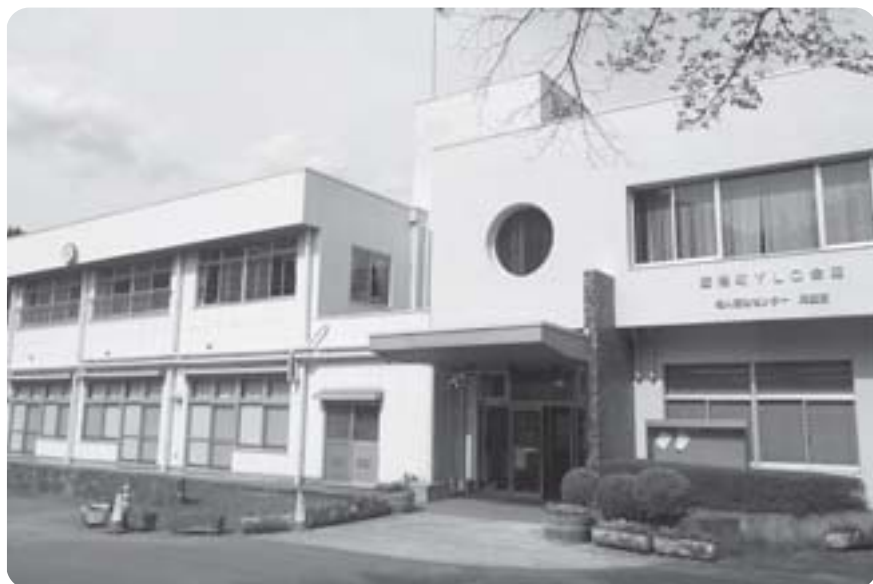
改修工事が実施されるYLO会館
