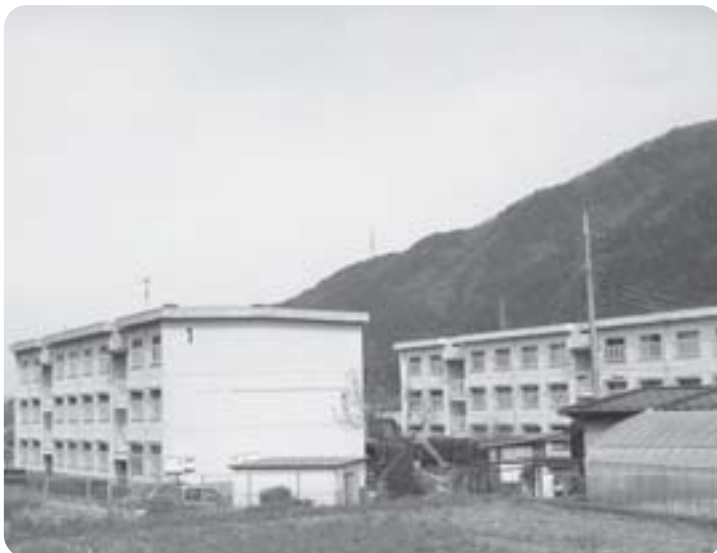
浅間団地（2棟）屋根防水工事予定
