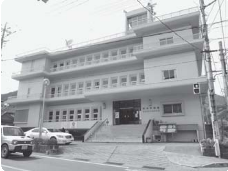
築45年が経過している役場庁舎
