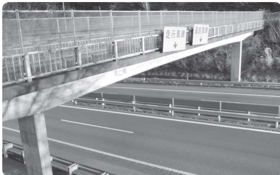
撤去が予定されている溝上橋
