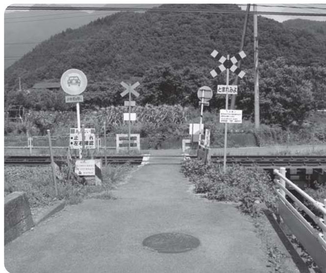
簡易踏切設置予定場所
