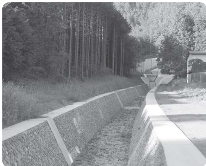
県事業の砂防工事が進む宮作地区
