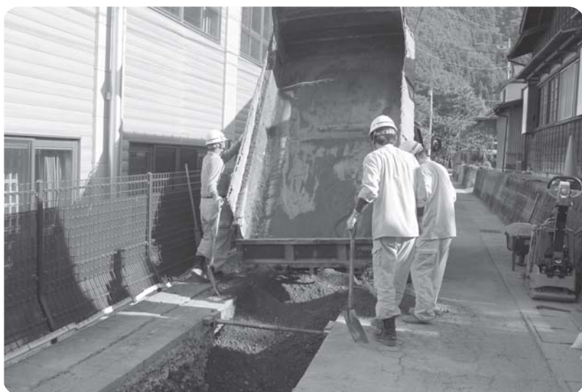
下水道工事が進む小学校体育館付近
