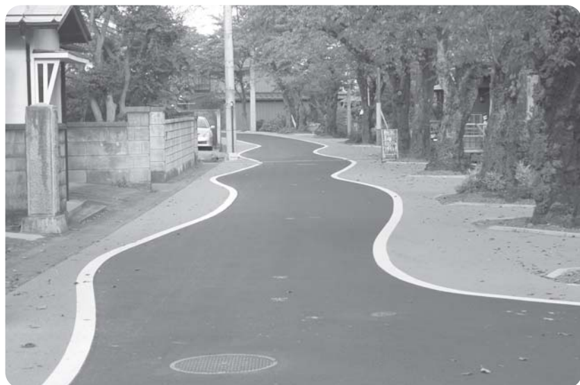
小沼中央線の舗装整備完了
