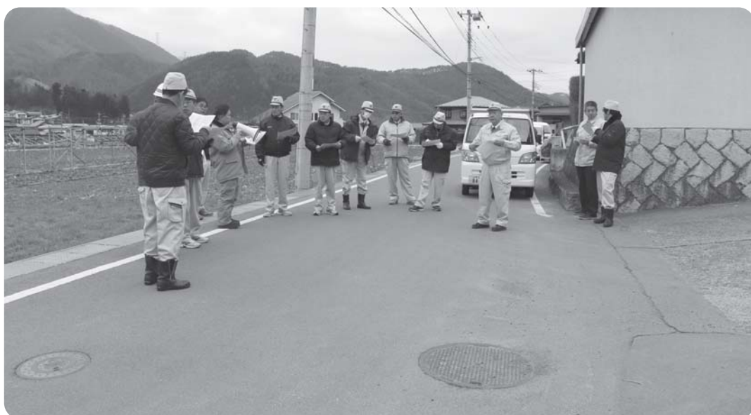
水道本管布設替工事現場視察
