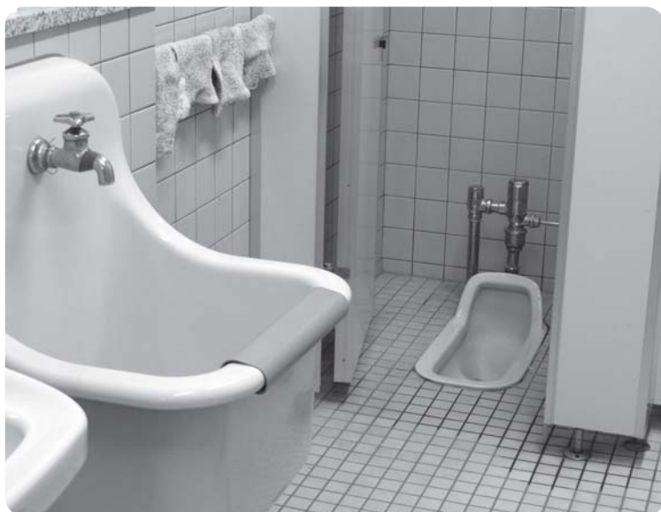
洋式に改修予定の小学校トイレ（北館）
