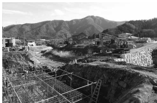
(仮称) 宮作橋下部工工事
