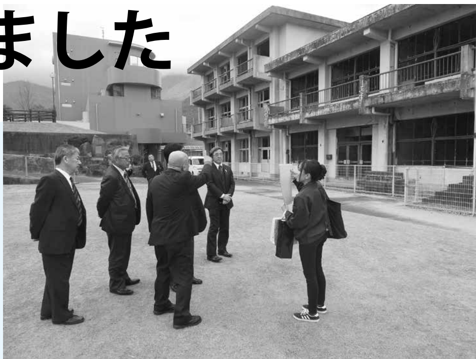
旧大野木場小学校被災校舎
