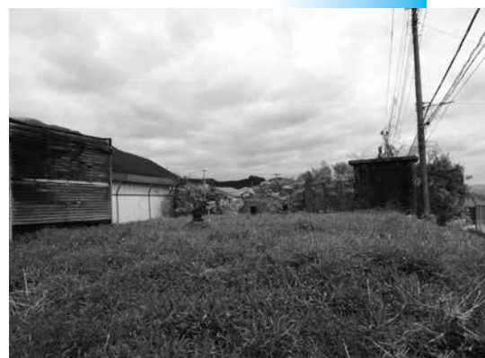
旧低区配水池受水槽撤去工事施工予定地
