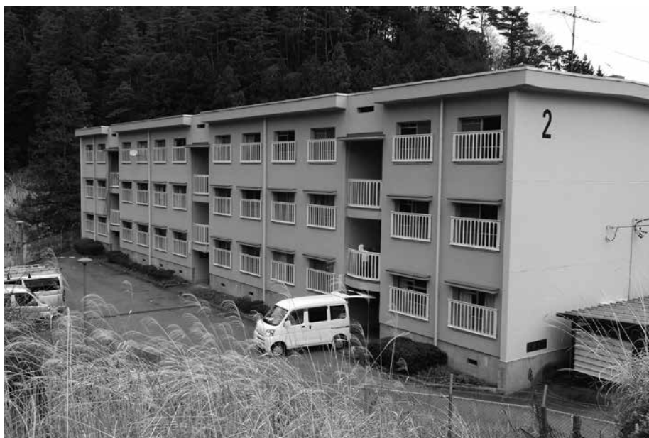
水回りの改修を行う町営住宅中野団地
