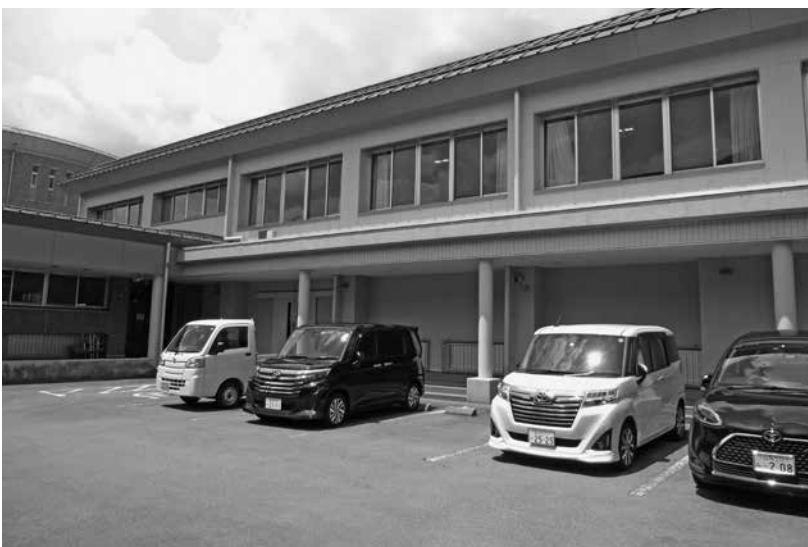
避難所機能の強化と熱中症対策のため空調設備を設置した体育館
