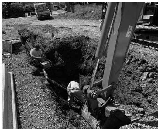
計画的に進めている水道管布設替工事
