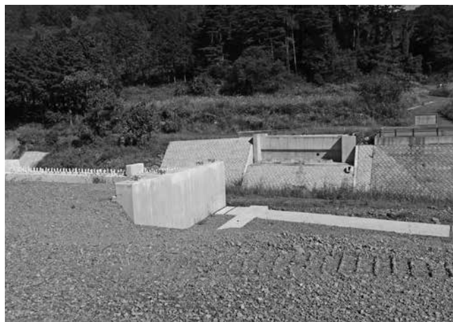
国庫補助金を活用して建設中の宮作橋
