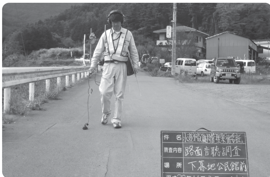
漏水探知器による漏水探査の様子
