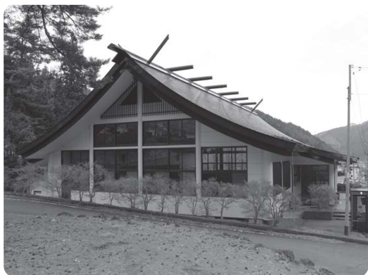
改修予定の武道館
