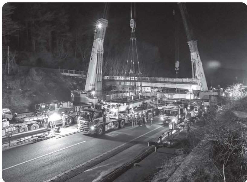
跨道橋撤去作業
