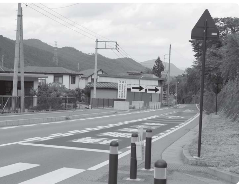
安全確保のためにも未着工区間の工事完了・供用開始が重要
