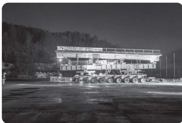
撤去された跨道橋
