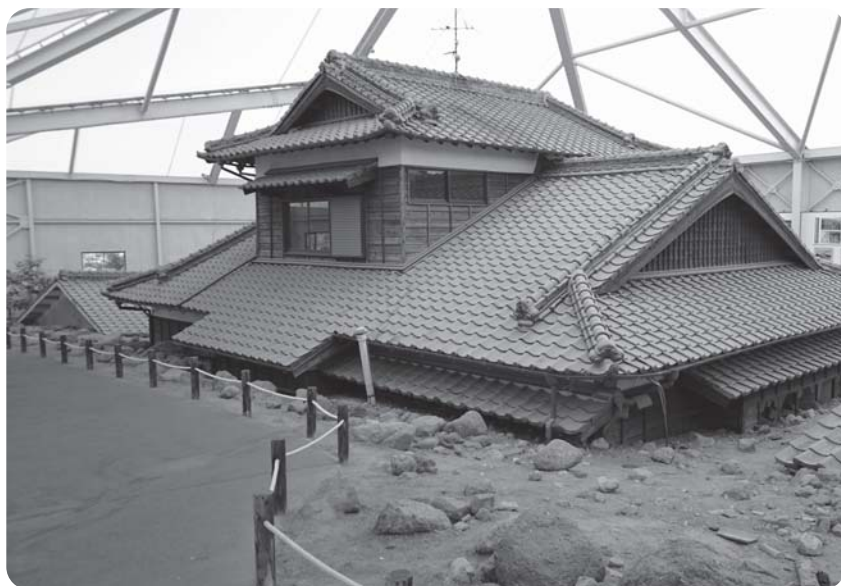
雲仙普賢岳の土石流による被災状況を視察
