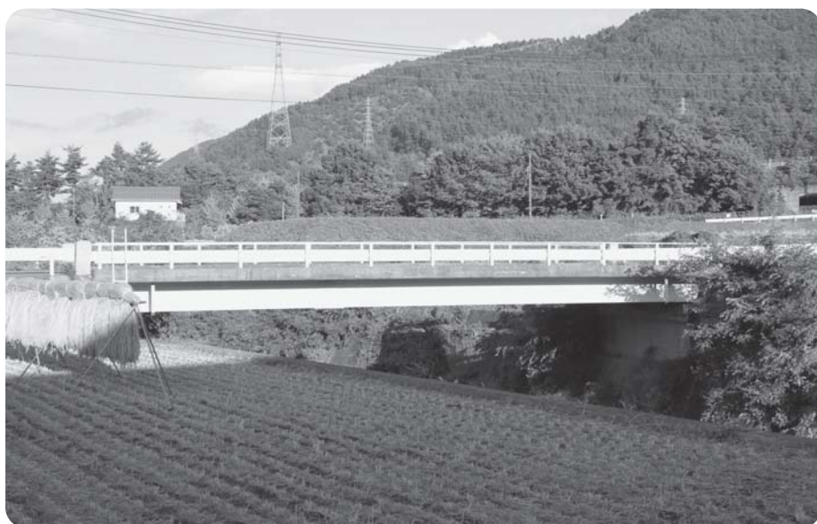
補強・補修工事が終了した桂大橋
