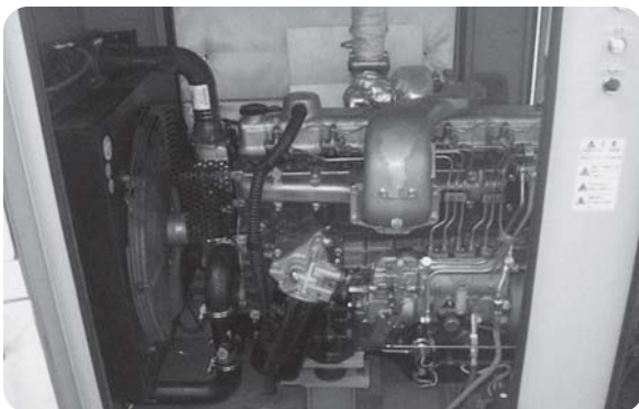
ウォーターポンプ（新高区配水池）
