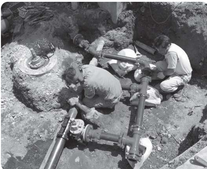
水道管切替工事（下暮地）
