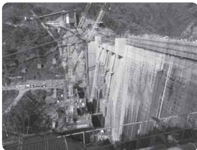
工事中の八ッ場ダム
