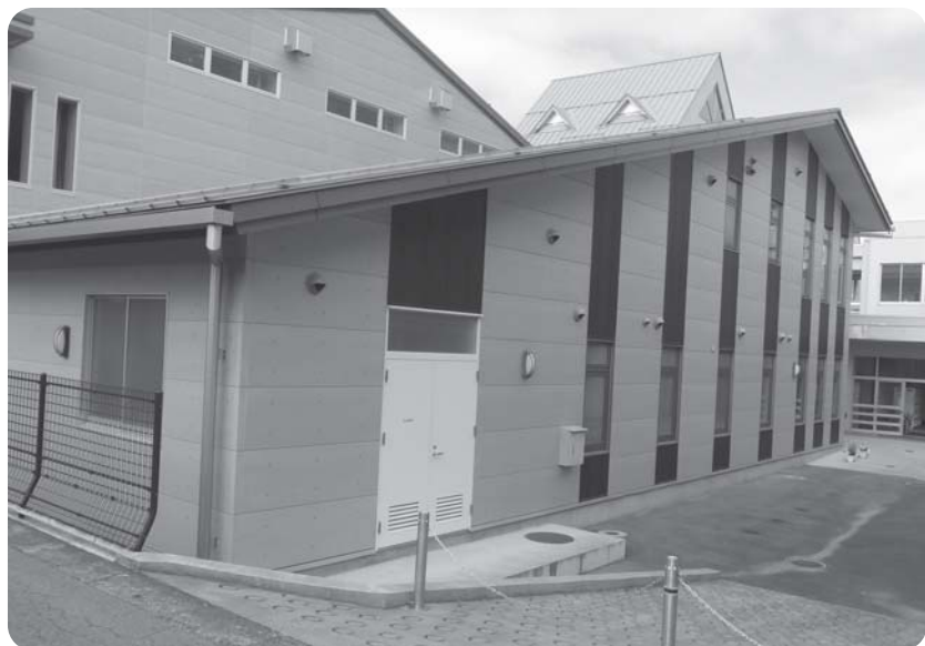
西桂小学校体育館横防災倉庫
