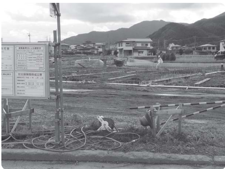
建設中のパルシステム山梨西桂センター
