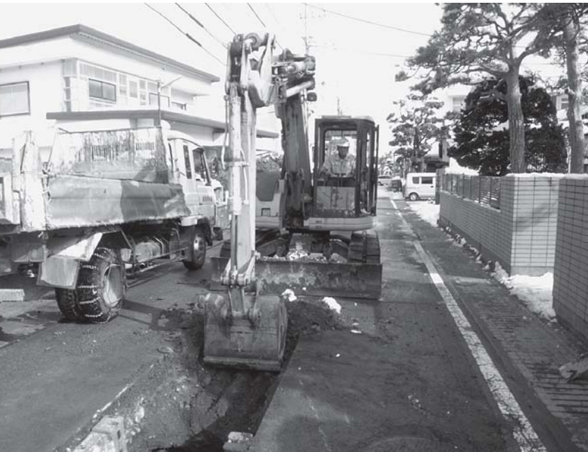
本町地区の下水道管渠布設工事
