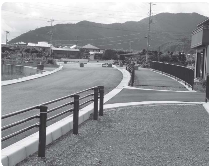
整備中の県道富士吉田西桂線の上町未整備区間
