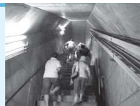
ダム内部の様子
