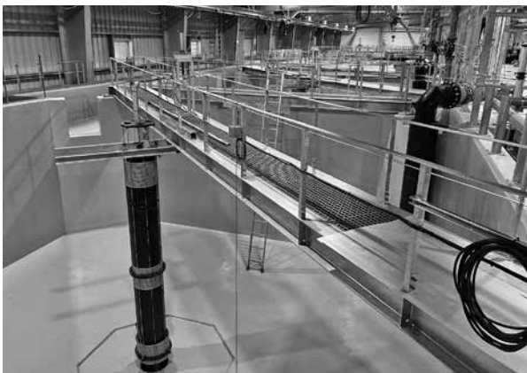
完成したサーモン養殖用水槽
