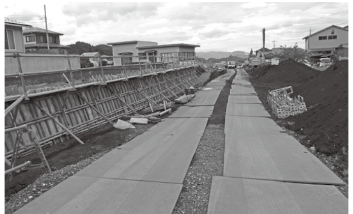
工事に着手した県道富士吉田西桂線(上町池の頭地区)
