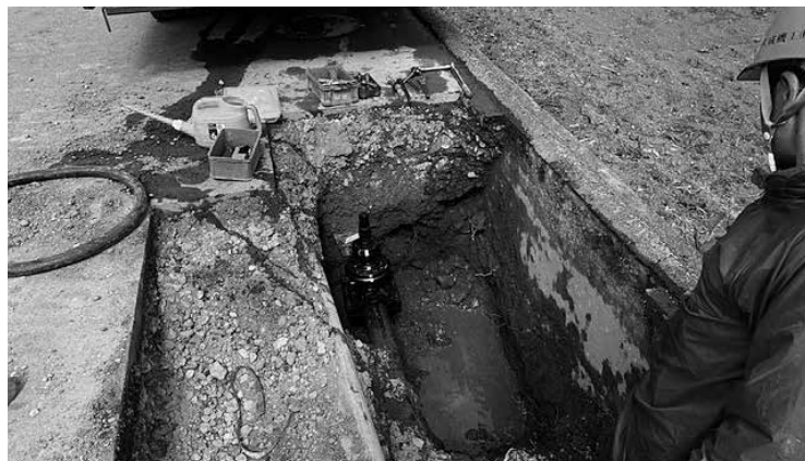
水道本管漏水修繕工
