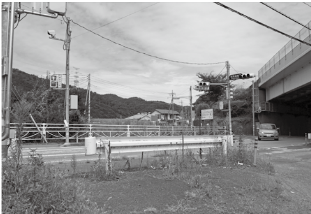
早期改良工事を望む桂高架橋下交差点
