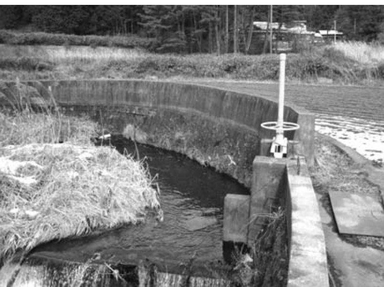
ゴミ処理の難しい滝入水門
