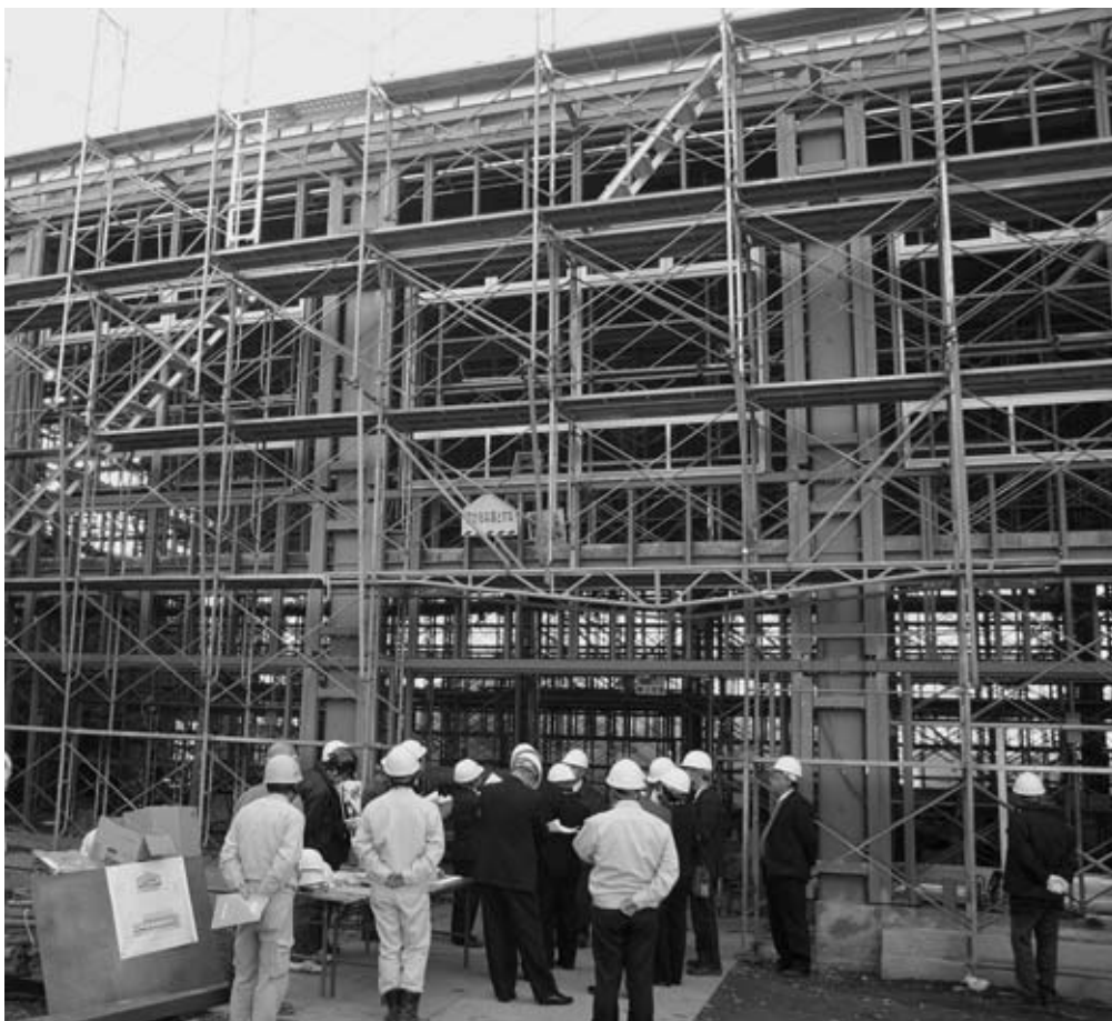
建設中の西桂小学校屋内運動場
