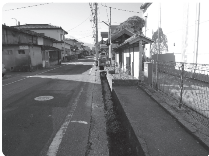
溝ぶたのない側溝（小沼中央線）
