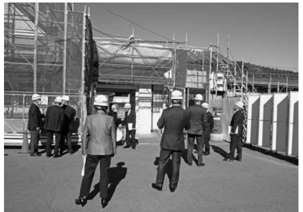
三ツ峠駅舎現場視察
